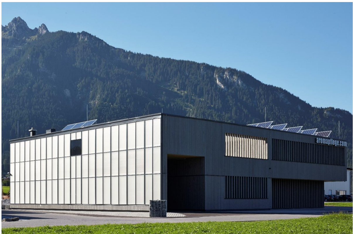
Abbildung 8: Aussenfoto Südseite mit Sonnenkollektoren
